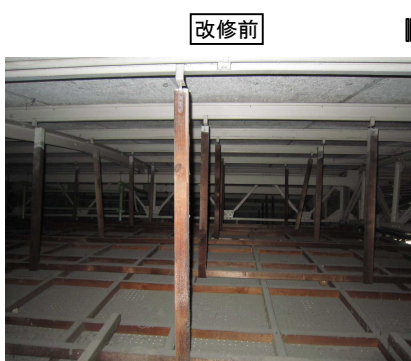
既存天井下地(木下地)
