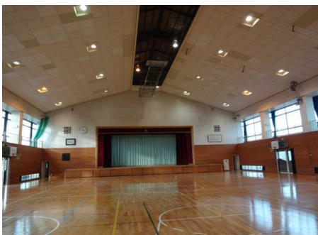
落下防止対策実施前の天井
