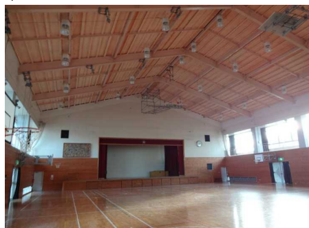
天井撤去工事施工後の状況
