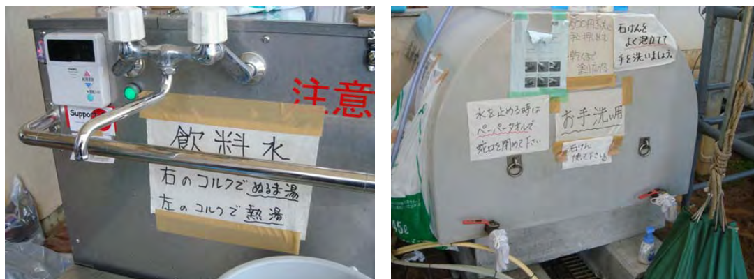
小型給水車のタンクを据え置き、大型給水車から毎朝補充して使用 飲料用と手洗用を分けて使用（左：飲料用、右：手洗用）
