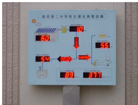
リアルタイムで太陽光発電量と購入電力量を同時に表示 （静岡県島田市立島田第二中学校）
