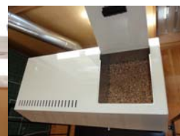
ペレットストーブに燃料(ペレット)が入っている状態
