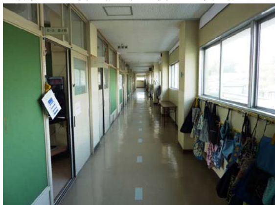
片廊下（左側が教室、右側は外部、晴れ）
